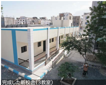
完成した新校舎(3教室)
