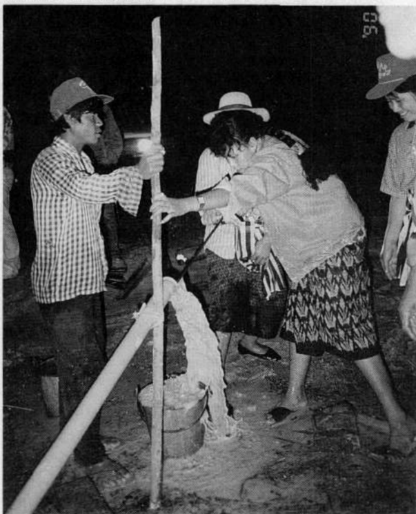
▼女性たちが中心となって井戸を掘る
