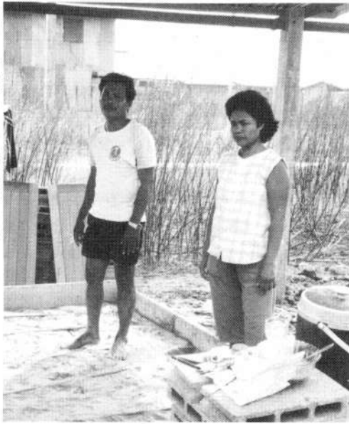
夫婦・兄弟等による住宅建設現場 (サイト・アンド・サービス事業)
