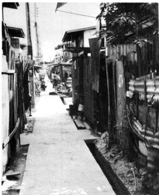
スラム改善事業により歩道、排水、電気が整備。
