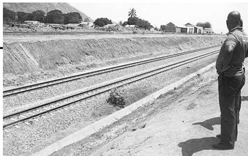
整備されたナカラ鉄道。3m近く深く掘られ、長距離に渡り陸橋が設置されておらず転落事故などが多発
