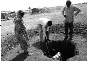
掘削中のトイレ。深さ3メートルまで掘削する
