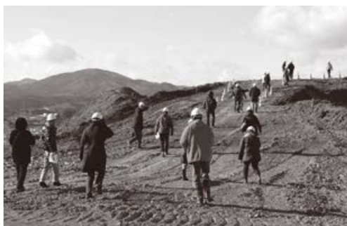
大浦地区高台移転の造成地を見学する
