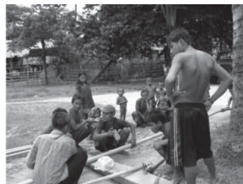
■村人と協働での井戸の修理。
