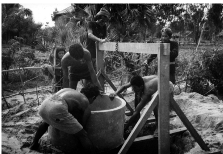
■JVCがセメントを、村人が労力を負担して井戸を作る。井戸を利用する世帯で「井戸掘り委員会」を作り、利用ルールを決める。
